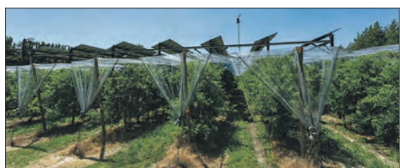
Les persiennes photovoltaïques ont livré leurs premiers résultats dans les Bouches-du-Rhône.
